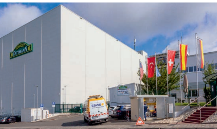
Neue Gasdruckregelanlage in Taunusstein.
