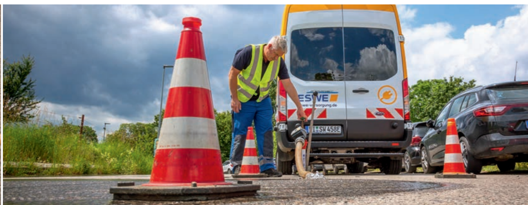
Turnusmäßige Routinespülung der Wasserversorgungsleitung bei Bierstadt.
