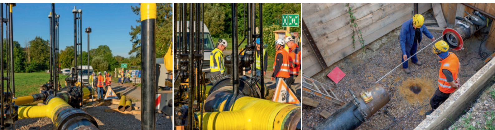
Erneuerung einer Armaturengruppe der 16 bar Gashochdruckleitung im Wäschbachtal.
