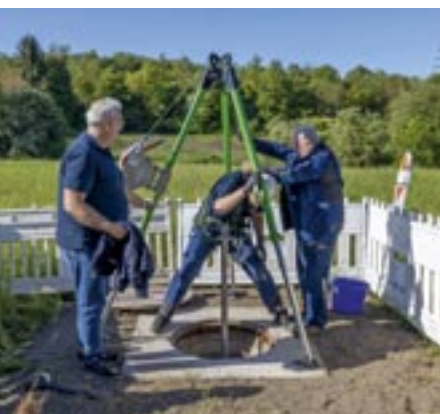
Hauptversorgungstunnel der Fernwärmeleitungen in die Stadt Wiesbaden.
