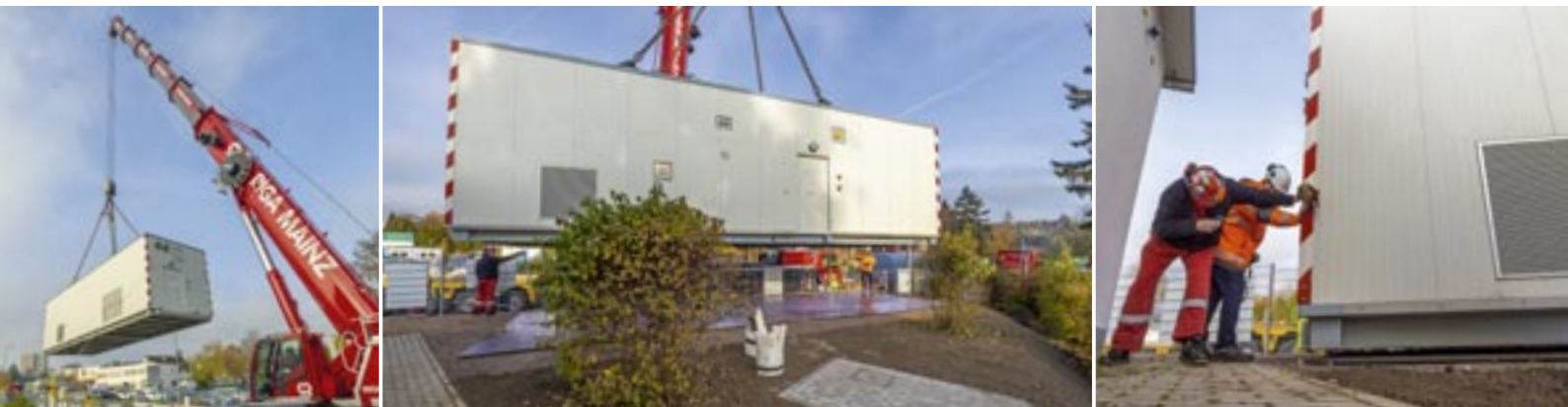
Aufbau der temporären Heizstation in Wiesbaden-Dotzheim zur Gewährleistung der Wärmeversorgung während geplanter Arbeiten.
