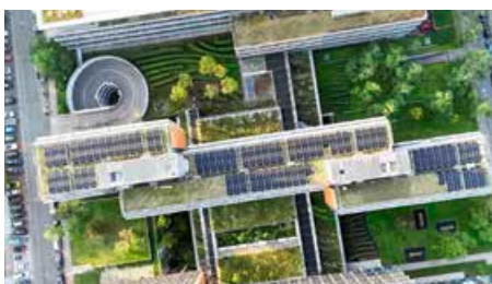
Blick von oben auf ein Gebäude der SOKA-BAU mit einer Solaranlage auf dem Dach
