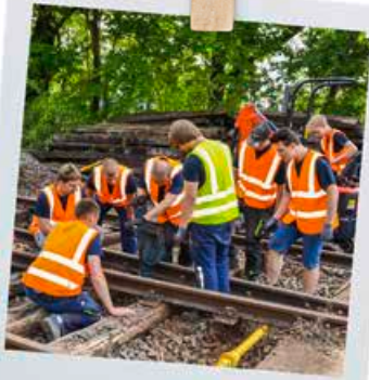
2023: ESWE-Azubis waren bei der Sanierung des Sommerbahnhofs der Nassauischen Touristik-Bahn e.V. mit dabei. Auch bei Gleisarbeiten packten sie mit an.
